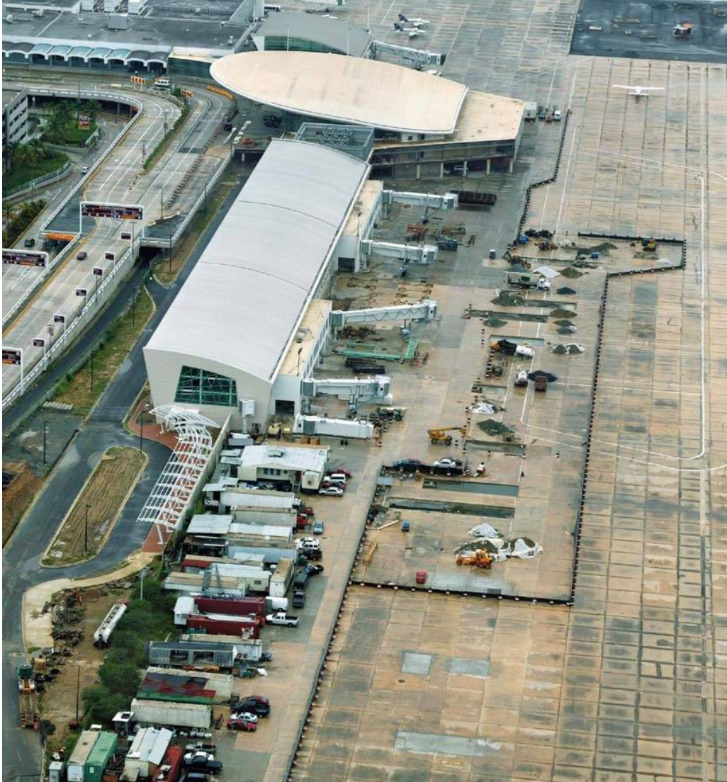
Vista aérea de la plataforma y nueva terminal de vuelos nacionales © QB Construction y fotografía aérea de la AAPA / Arquitectura, Inc
