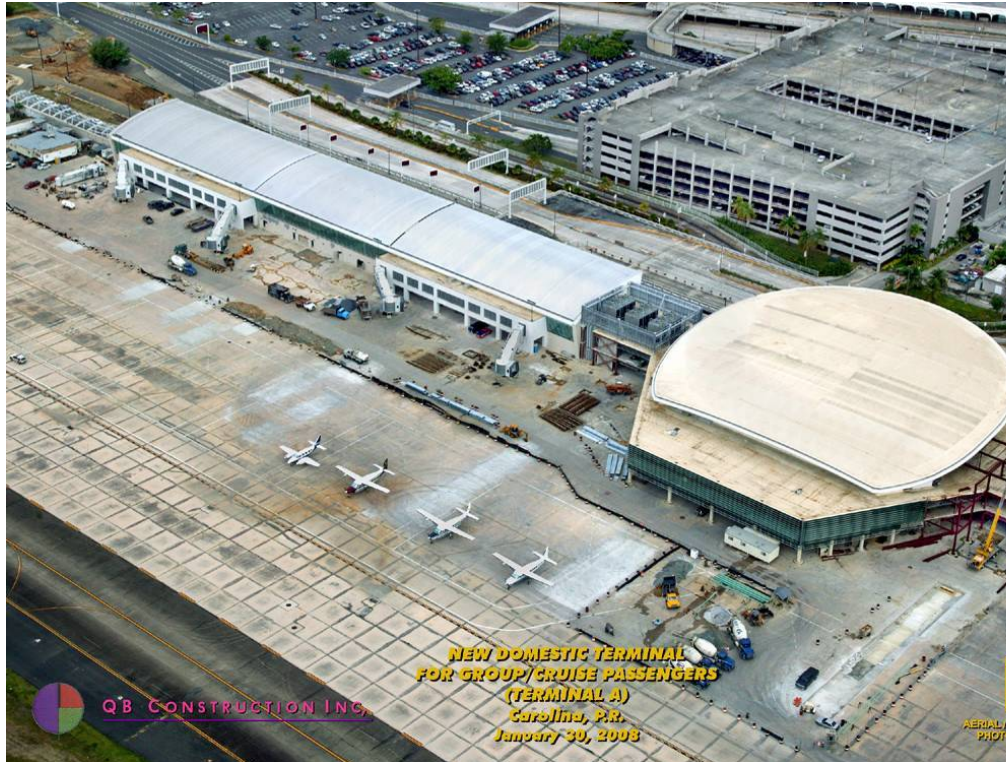
Vista aérea de la plataforma y nueva terminal de vuelos nacionales © QB Construction y fotografía aérea de la AAPA / Arquitectura, Inc.
